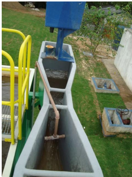
Foto 5 - Entrada da água bruta e adição de sulfato de alumínio (ETA compacta - Calha Parshall)
