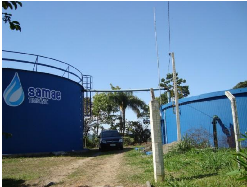
Foto 40 – Conj. de Reservatórios R. Rodeio
