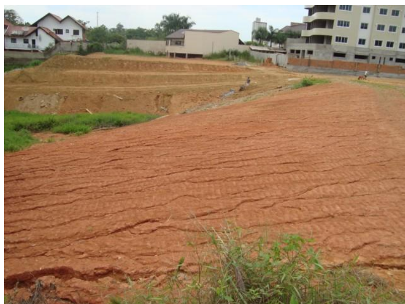
Foto 70 - Exemplo de terraplenagem no município
