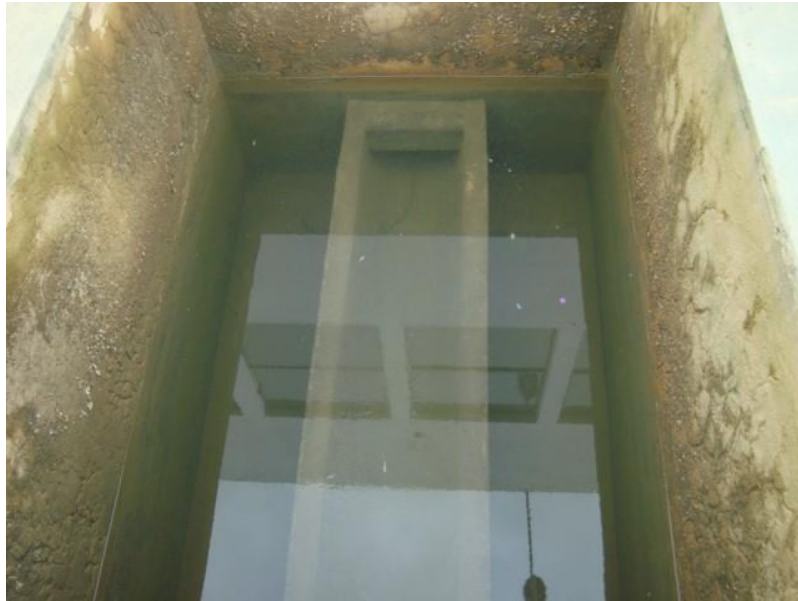
Foto 10 - Filtro rápido de duas camadas
