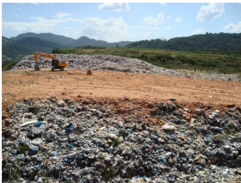
Foto 57 - Operação de compactação
