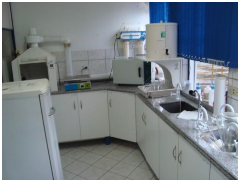
Foto 11 - Laboratório da ETA
