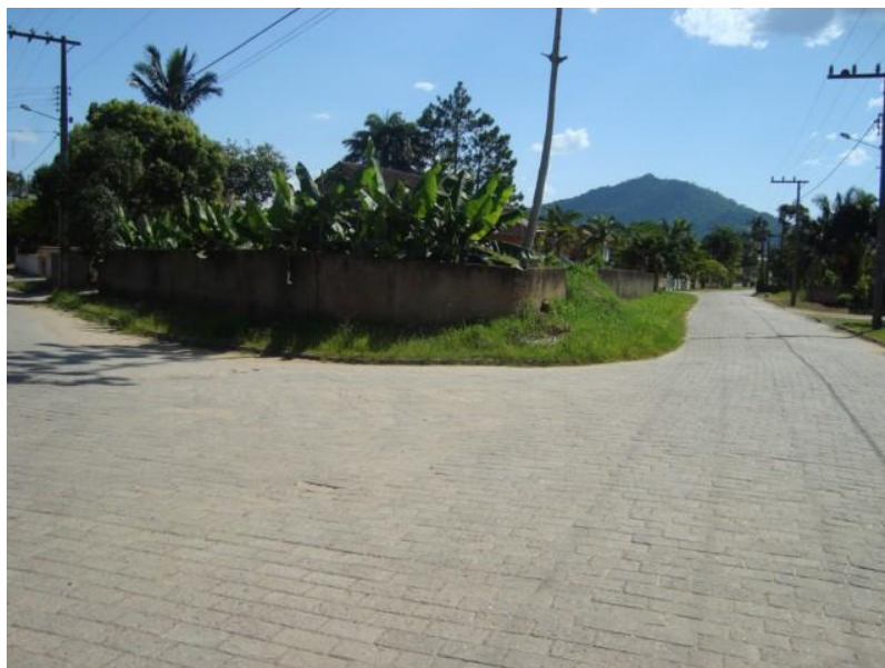
Foto 63 - Rua Haiti (Ponto de alagamento)
