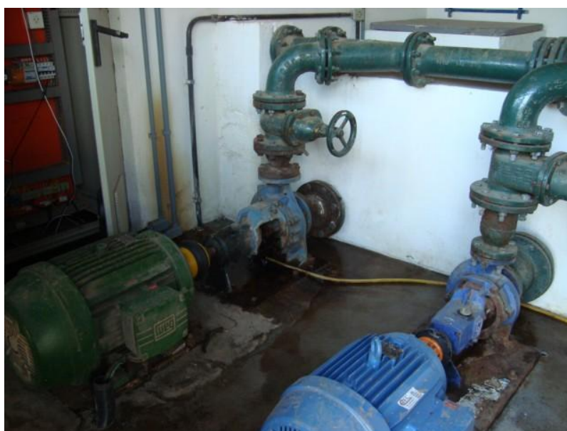
Foto 19 - EEAT Rua Groelândia (interno)
