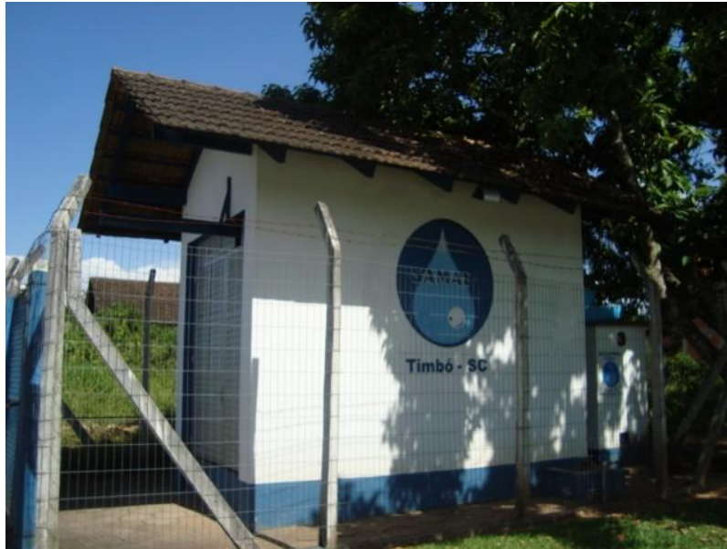
Foto 16 - EEAT Rua Quintino Bocaiúva
