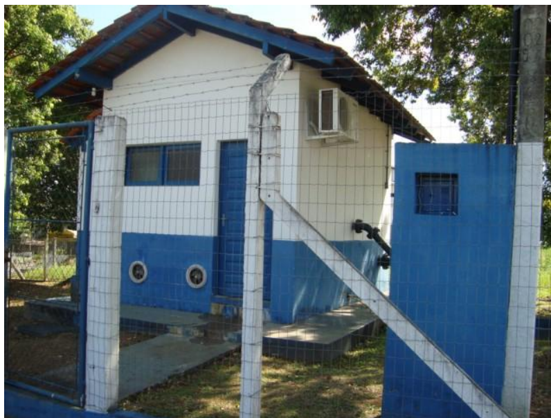
Foto 18 - EEAT Rua Groelândia
